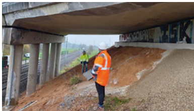
Après les travaux
