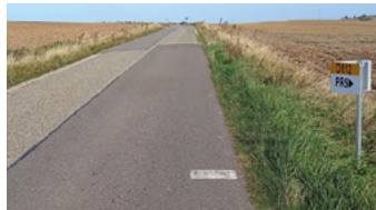
Après les travaux
