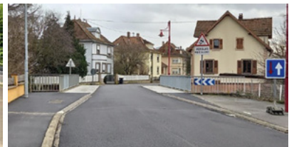
Après les travaux
