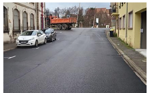
Après les travaux
