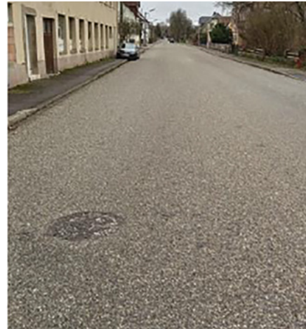
Après les travaux
